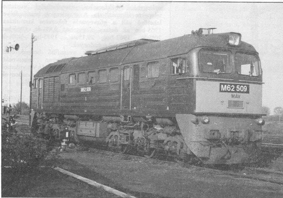
M 62,509 psz. széles nyomtávú mozdony
